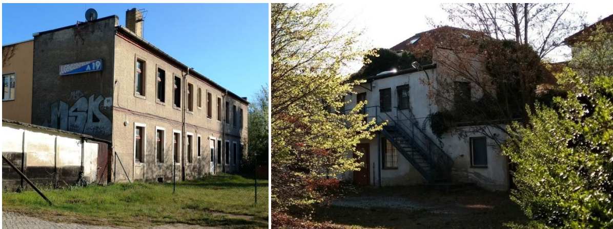
Abb. 17: Fotos der beiden Gebäude im Hinterhof der Augsburg Str. 28 (April 2020) – eins davon war Sitz der Maschinenfabrik Summus-Compagnie G.m.b.H. von 1907-1909
